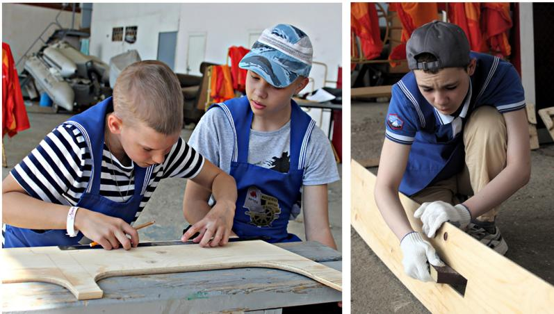
Конструкция швертбота «Оптимист» проста и технологична, поэтому постройка лодок этого типа успешно освоена в Международном детском центре «Артек». Будущие яхтсмены самостоятельно выполняют все работы, что позволяет им досконально изучить конструкцию судна и получить полезные навыки, которые обязательно пригодятся в жизни.
